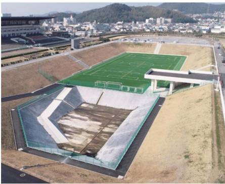
姫路競馬場内に整備された船場川の洪水調節池。25haプール約400個分という県下最大の規模で、平常時にはサッカー場として利用できます
